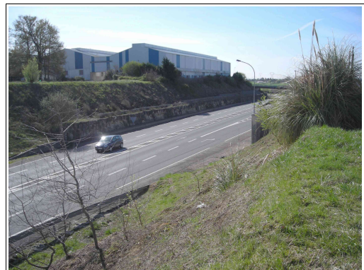
Contournement routier de Saintes, quelques instabilités de terrain affectent les talus. En arrière plan, un gabion a été posé à mi-pente pour caler le terrassement.
