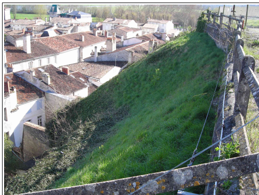
Ancienne niche d'arrachement visible à l'amont de la falaise du site Saint-Louis. Les glissements de terrain sont à ce niveau étroitement liés aux phénomènes de chutes de blocs.
