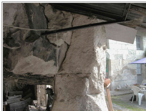
Bordure de la carrière 51, on notera l'état du pilier, dont le porte à faux créé par la fissure verticale.
