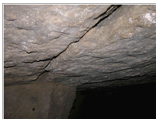
Intérieur de la cavité 74 située en partie sous la rue Cabaudière, plusieurs fissures parcourent le plafond et d'autres concernent des appuis. La circulation de la rue peut contribuer à l'évolution de cette fissuration.
